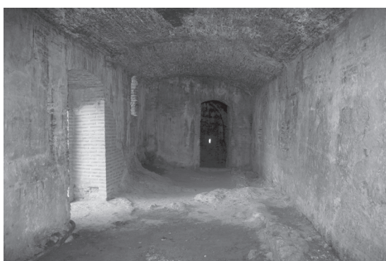
Figura 12. Interior de les cavalherisses (Foto E. Moscardó).
