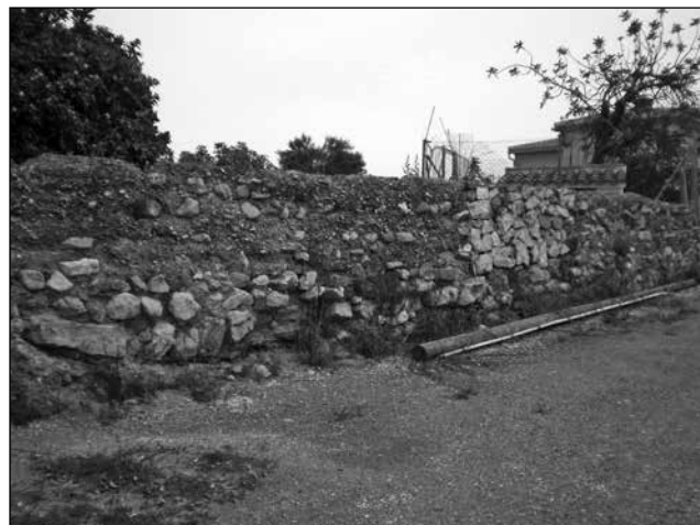
Figura 3. Fotografia del mur de tàpia de Benimaquia. Font: pròpia.
